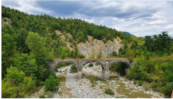
Brücke in Rapallo / Italien (Foto: M. Eigner)
